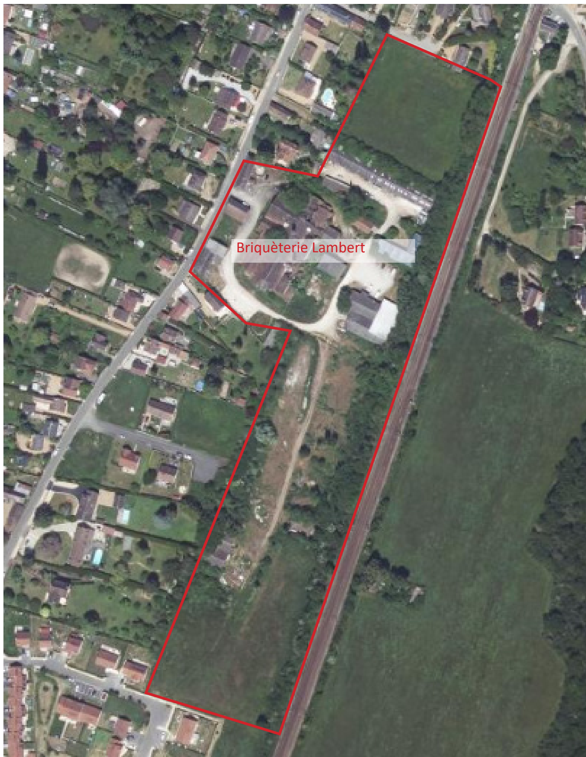
Vue aérienne de la Briquèterie Lambert
